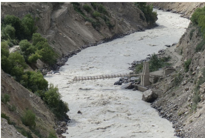
Brücke über den Braldo bei Hoto - einer der Pfeiler wurde weggerissen
