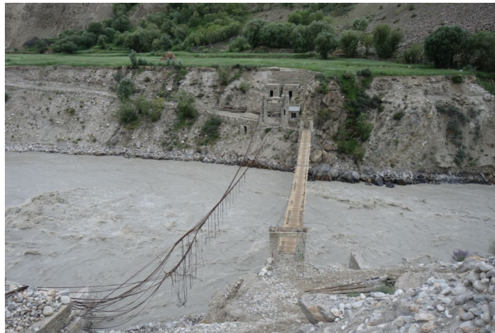
Die Reste der im Sommer 2024 zerstörten Brücke bei Kurphe und die von uns gebaute Fußgängerbrücke
