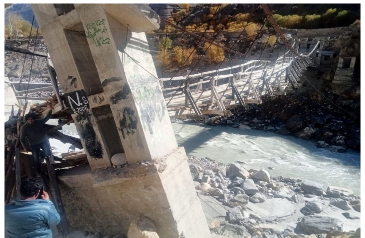
Der Brückenpfeiler wurde im Juli vom Hochwasser weggerissen
