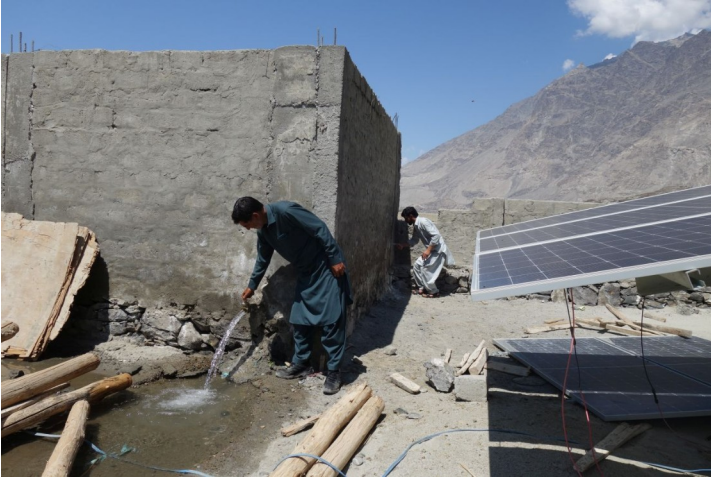
Die Solaranlage für die Grundwasserpumpe
