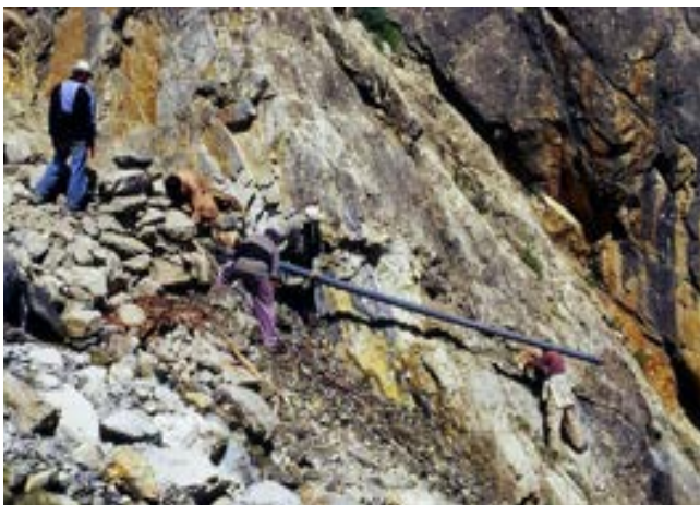
Bau der Wasserleitung in schwierigem Gelände
