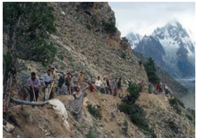
Das ganze Dorf half bei den Bauarbeiten
